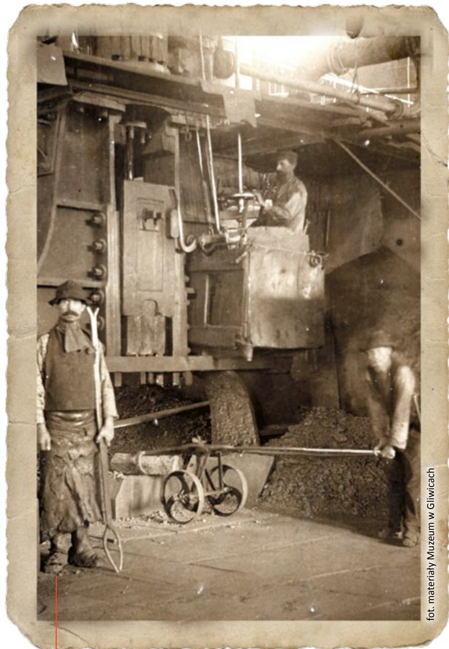
Młot parowy w hucie Hermina w Łabędach, 1906 r.
