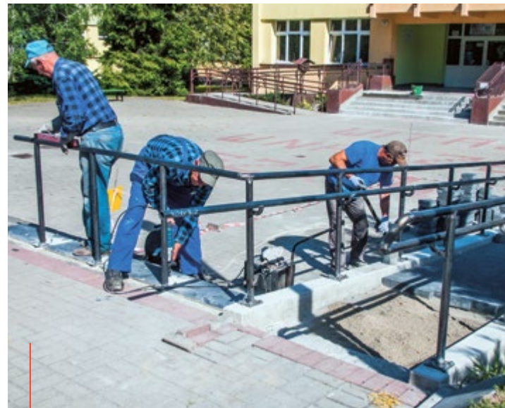
Przy ZSO nr 8 montowana jest pochylnia dla osób niepełnosprawnych, remontowane są schody wejściowe do budynku oraz wymieniane jest pokrycie całego dachu
