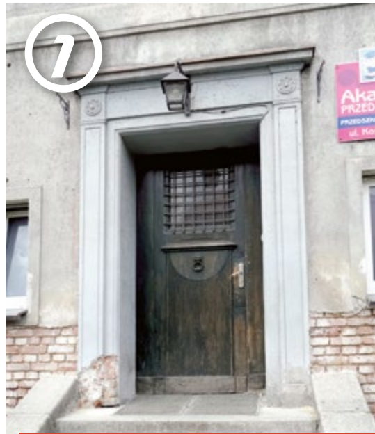
Gliwice, ul. Kościuszki 25 przed remontem...
